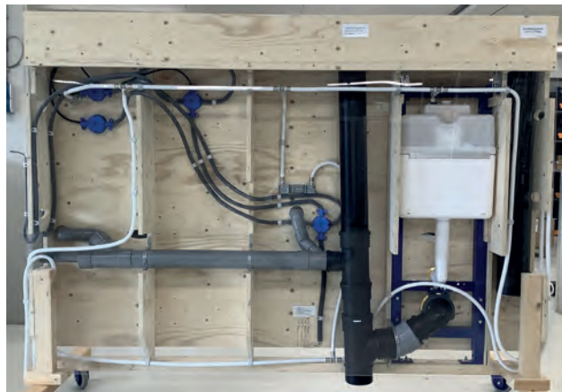
Boven: de prefab wandkast met installatiecomponenten past exact in het systeem van de wandenbouwer (foto: Winkels Techniek).
